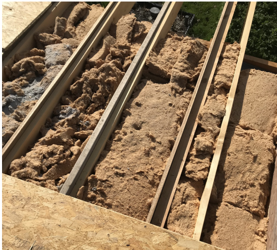
Pose d'isolants dans la toiture plate du BRIC2
