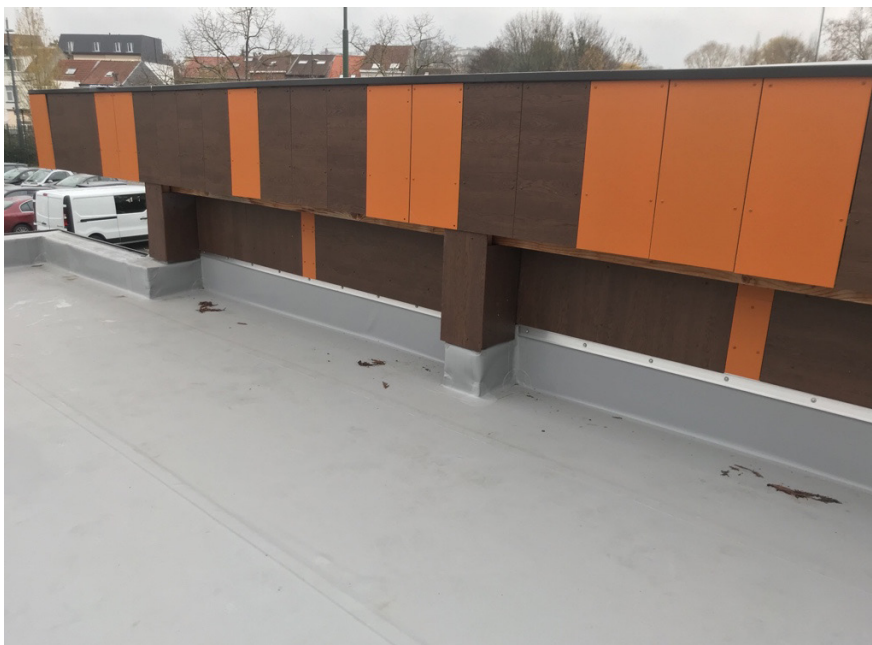
Détails des solins (raccord panneaux de finitions/ solins/ Vaeplan)
