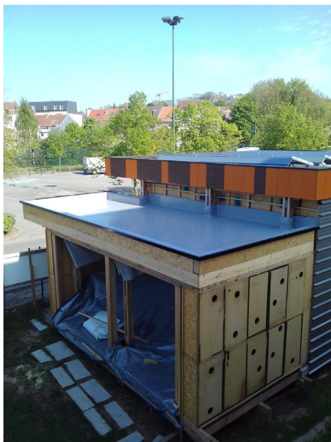
Vue sur la toiture-terrasse de l'extension
