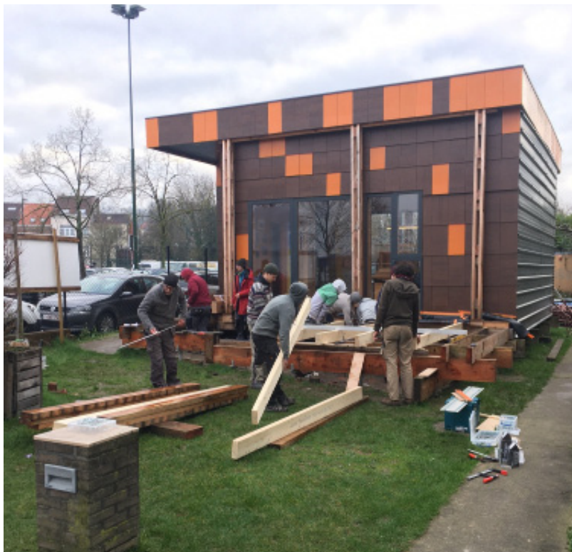
Démontage de la terrasse et installation du gitage intermédiaire Façade Nord
