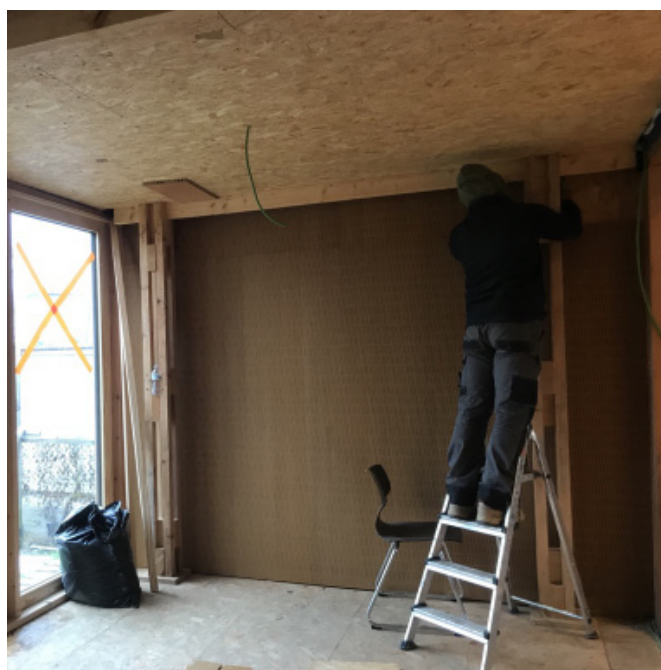
Stock de lattes acoustiques Assemblage des lattes Installation sur les murs (vue intérieure de l'extension) Détails de finitions des panneaux acoustiques
