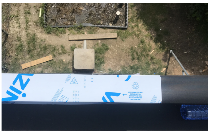
Couvertine vissée en débord
