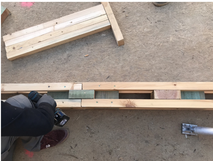
Détails d'assemblage de 2 colonnes
