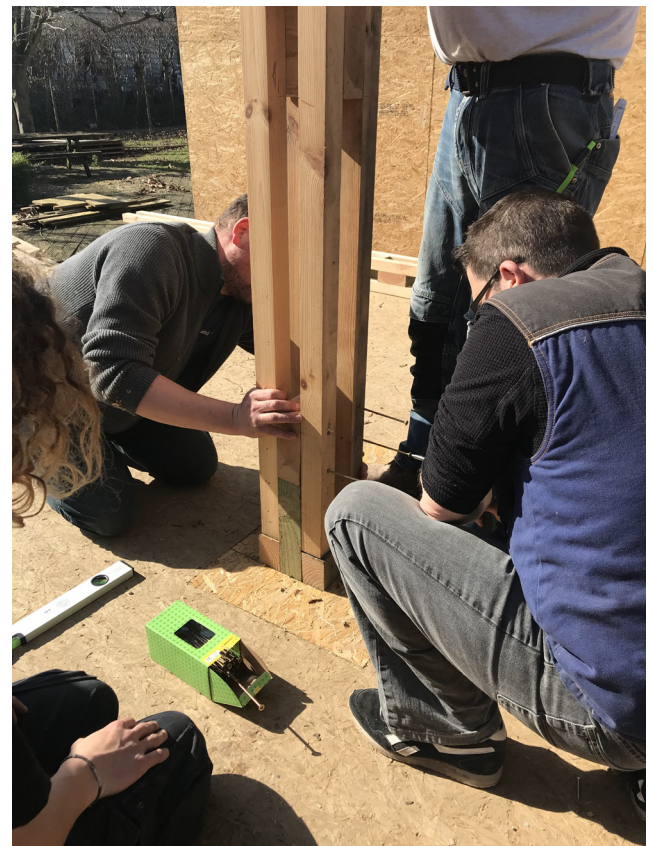
Pose et vissage de la colonne à chevrons sur le socle
