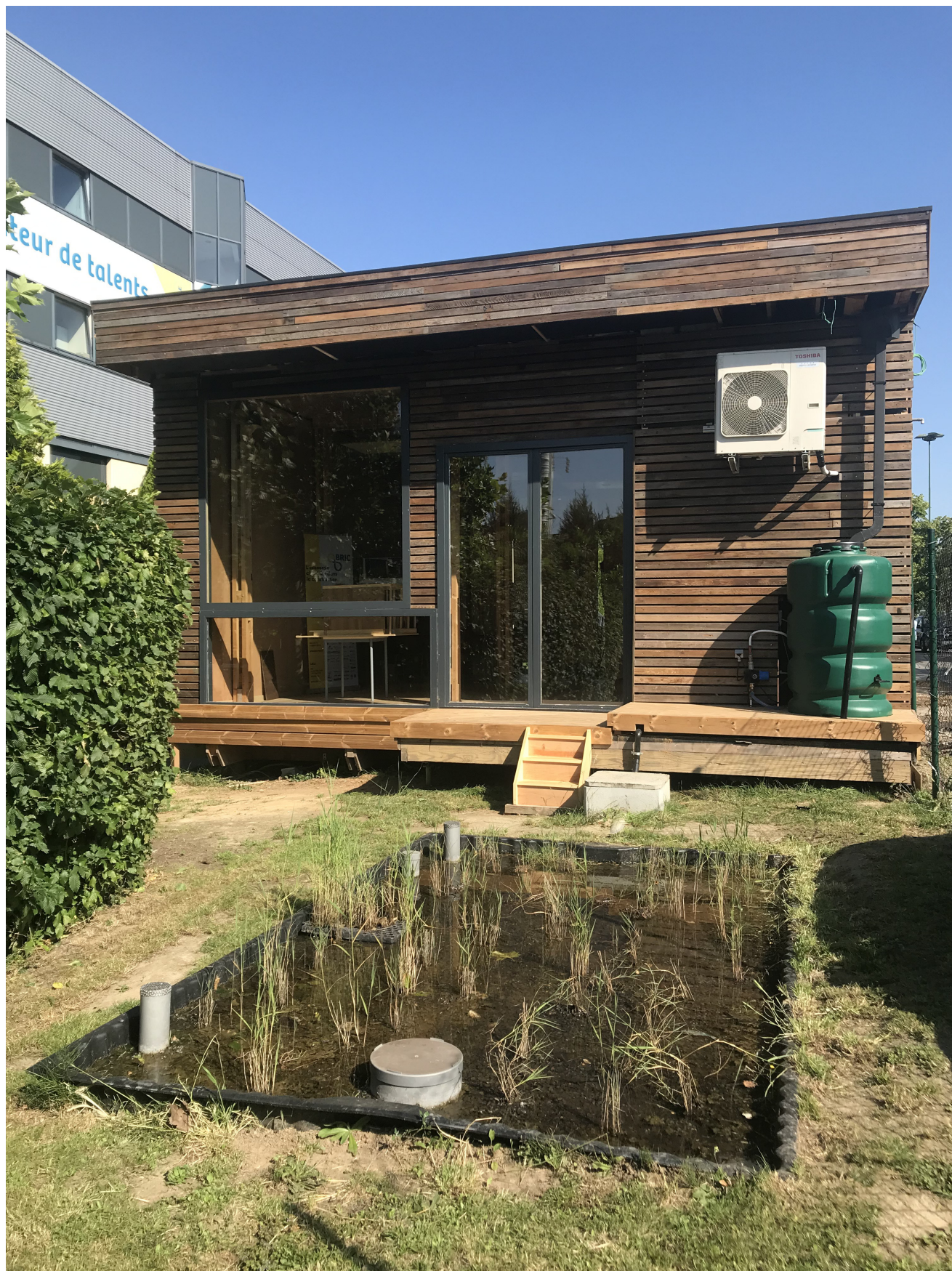
Vue sur les installations de récupération d'eau - façade Sud
