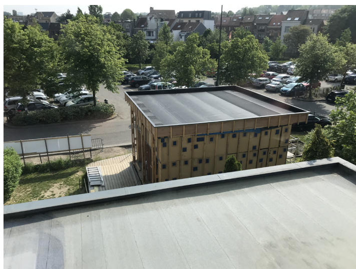
Couvertine vissée en débord
