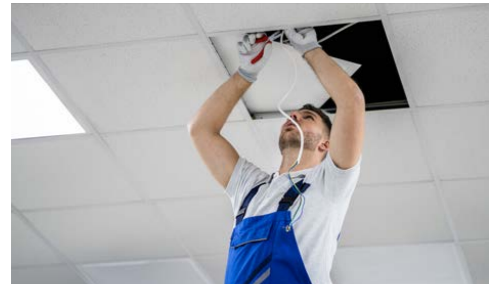
Figure 8 : Ces dalles de plafond peuvent être démontées de manière indépendante, sans avoir à retirer ou à endommager les composants adjacents.
