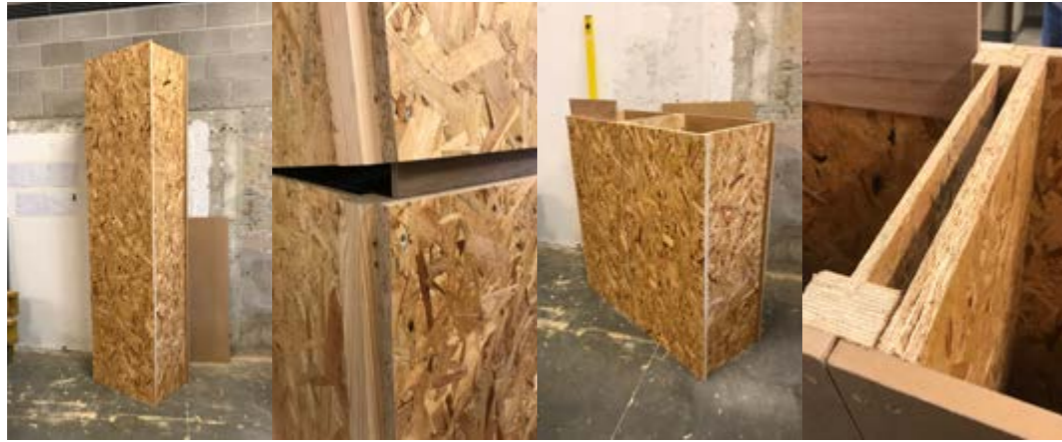
Figure 93 : Assemblage des éléments de parois (Source : Caroline Morizur, efp)
