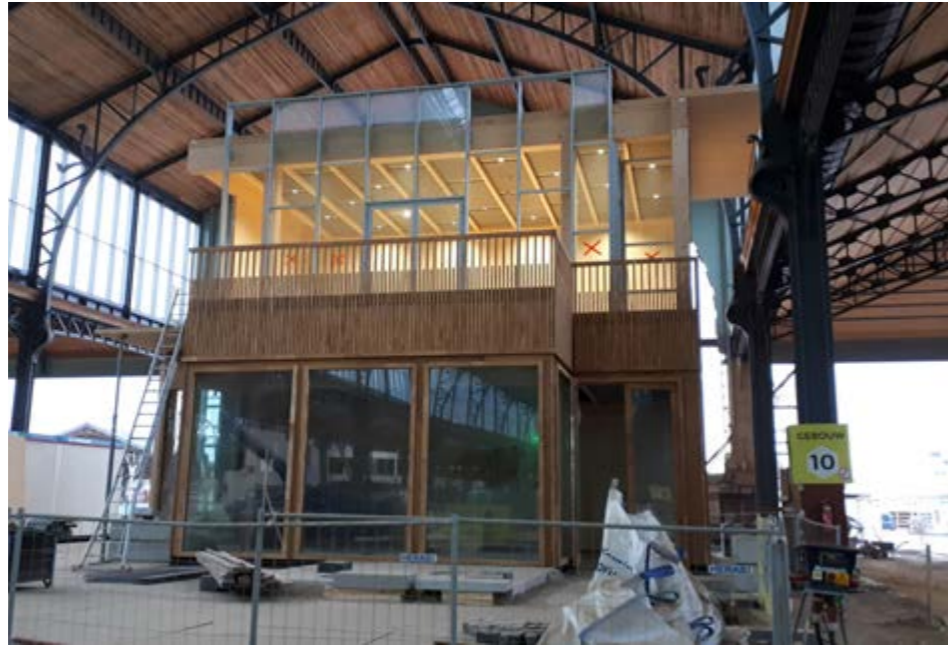
Figure 114 : Maquette de la Gare Maritime avant le démontage. (Source : Jansen AG)
