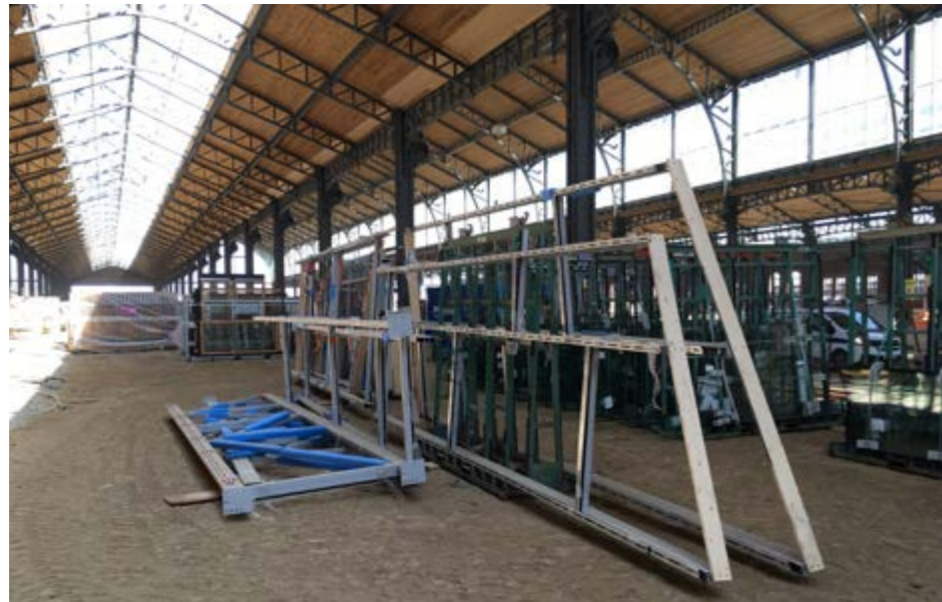
Figure 129 : Éléments préfabriqués stockés temporairement sur chantier. (Source : Jansen AG)
