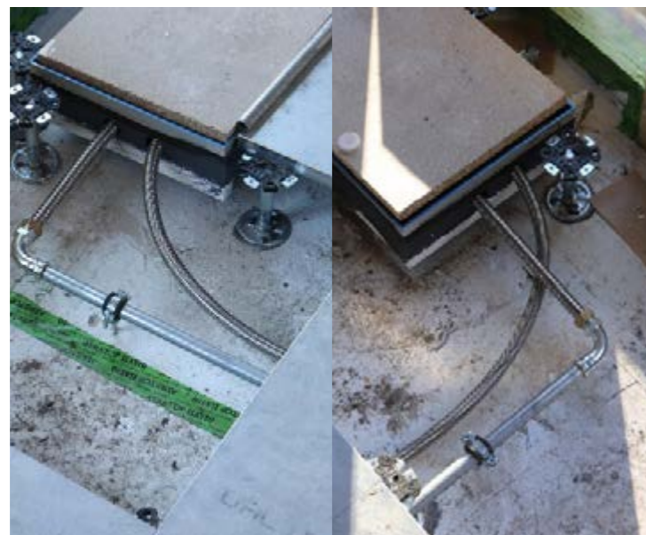
Figure 104: Indépendance totale: plancher surélevé démontable (Source: Architectural Engineering, VUB)
