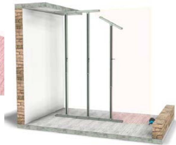
Figure 168 : Système de parois intérieures modulaire et démontable. Pose de la structure porteuse de la paroi dont les montants sont réglables en hauteur. (Source: JUUNOO)
