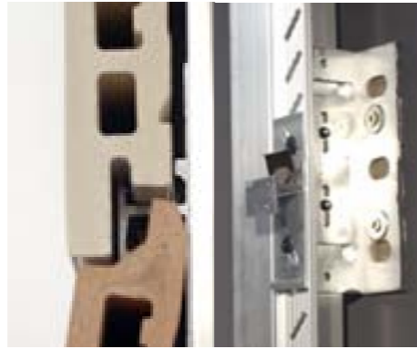
Figure 163 : Élément de base utilisé pour connecter le parement au module de façade (Source : Archipelago architects, Elma Durmisevic)
