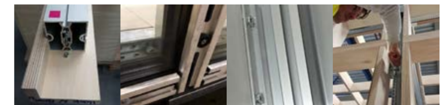
Figure 70 : Exemples de connexions indirectes. (Source : E. Durmisevic)
