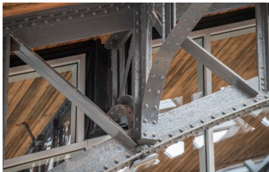
Figure 124 : Extérieur de la même façade avec une vue claire des techniques passant en douceur dans le raccord de la façade. (Source : Tim Fisher)
