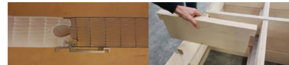
Figure 68 : Exemples de connexions par emboîtement. (Source : E. Durmisevic)
