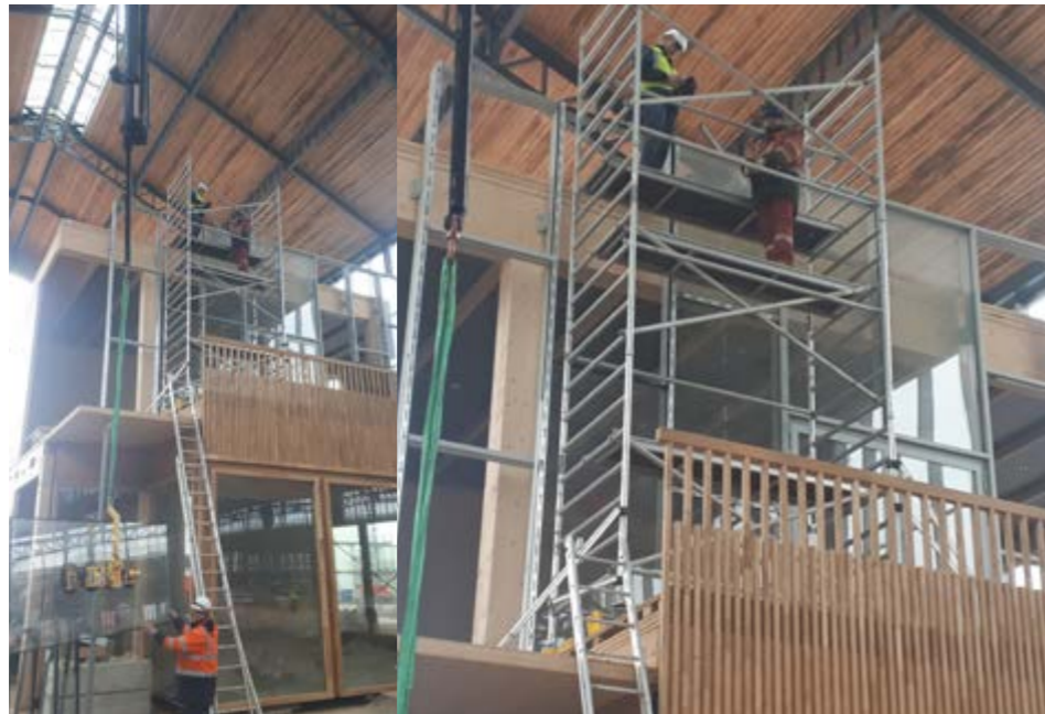
Figure 115 & 116 : Maquette de la Gare Maritime pendant le démontage. (Source : Jansen AG)
