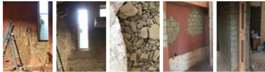
Figure 71 : Dépose de l'enduit d'argile dans le projet BRIC. (Source : Caroline Morizur, efp)
