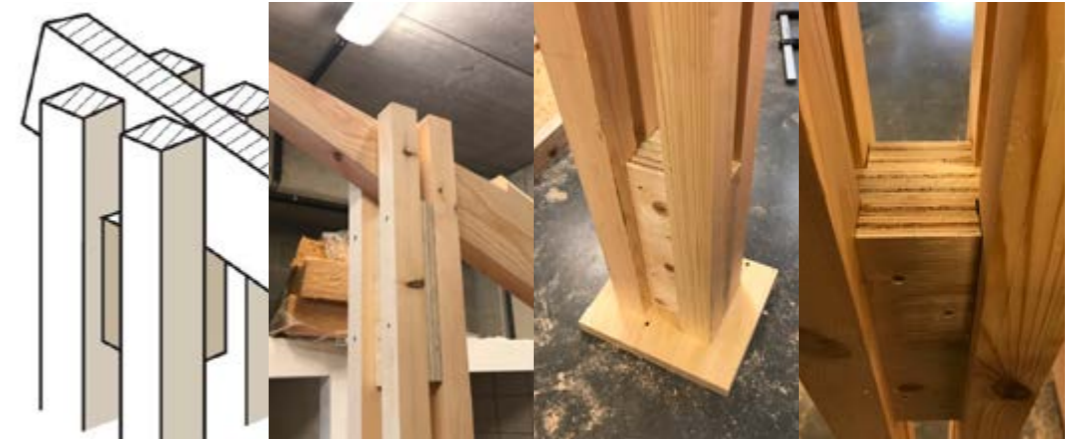
Figure 91 : Détails d'une colonne et de la connexion entre la colonne et une poutre (Source : Caroline Morizur, efp)
