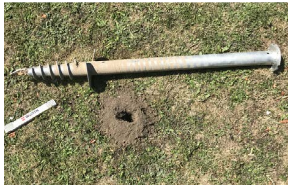
Figure 98 : Fondation réversible (Source : Caroline Morizur, efp)
