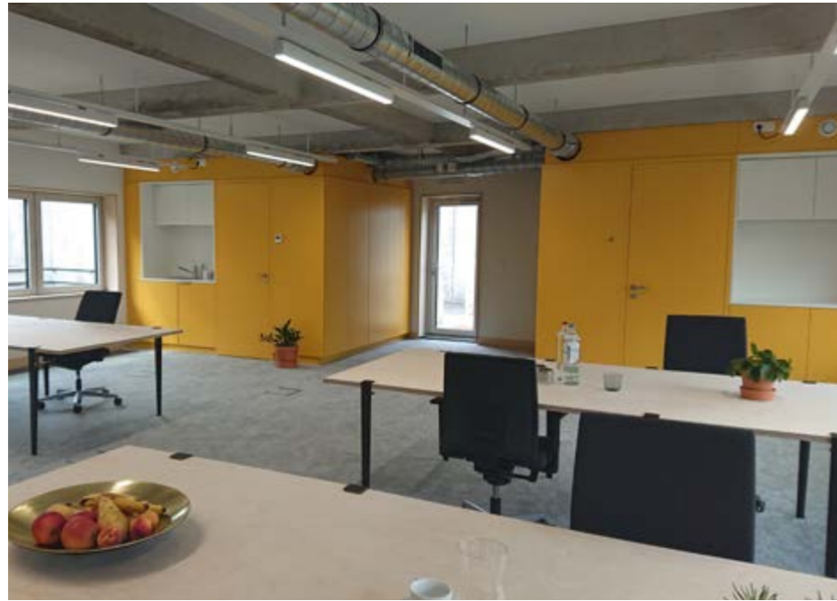
Figure 29 : Positionnement réfléchi des techniques horizontales et des cellules techniques et sanitaires dans le Circular Retrofit Lab.
