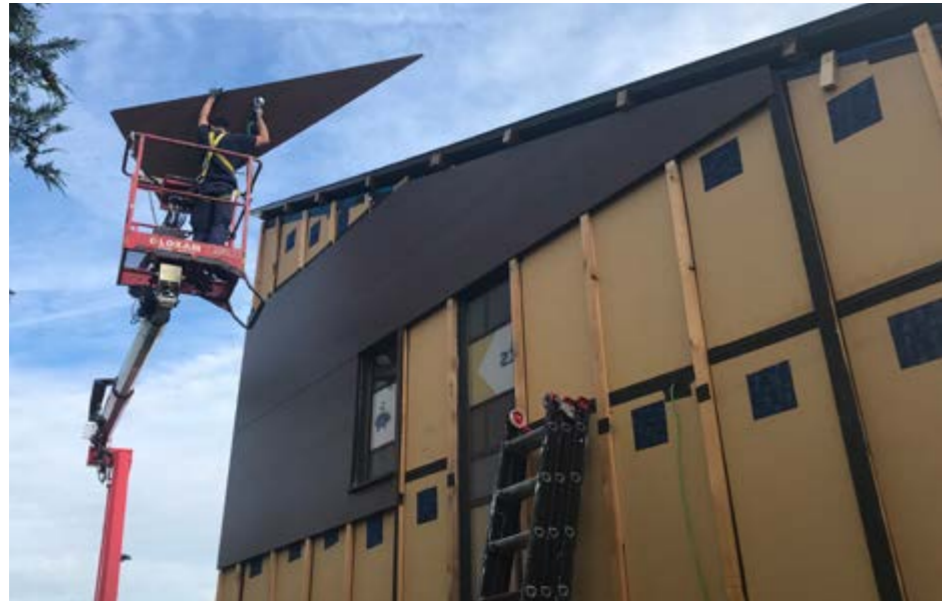
Figure 89 : Démontage des panneaux de parement (Source : Caroline Morizur, efp)
