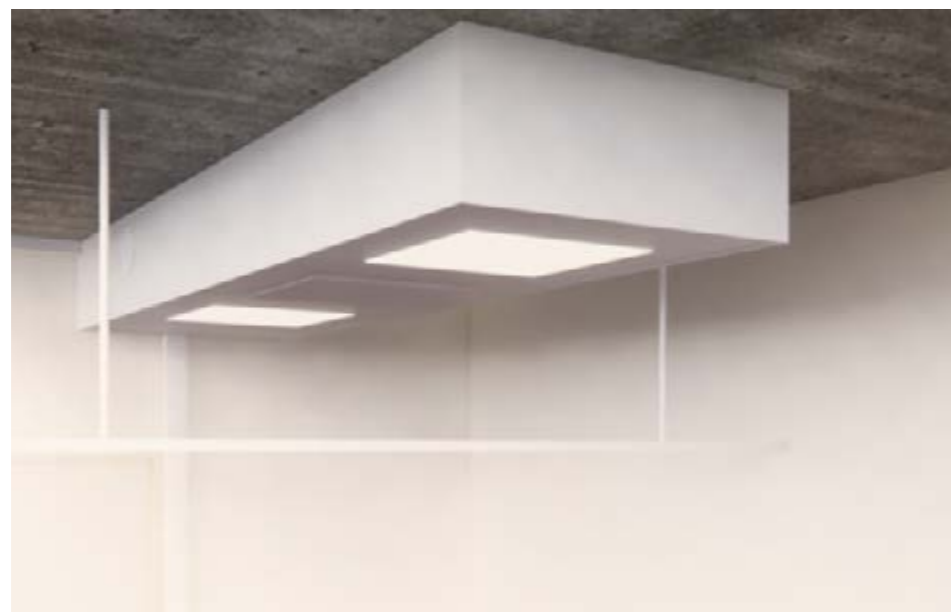
Figure 156 : L'îlot technique standardisé contient tous les équipements techniques nécessaires comme les luminaires et la ventilation (Source : archipelago architects)
