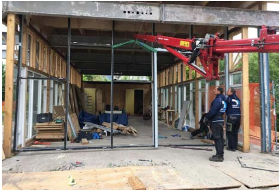
Figure 120 : Installation de la structure porteuse, deuxième phase. (Source : Blonkstaal)
