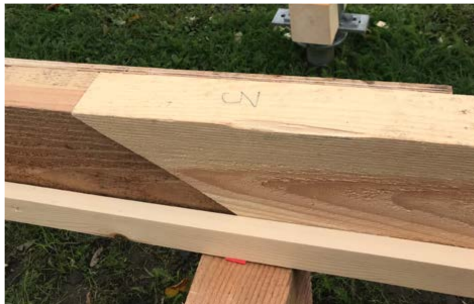
Figure 94 : Assemblage à sifflet. (Source : Caroline Morizur, efp)
