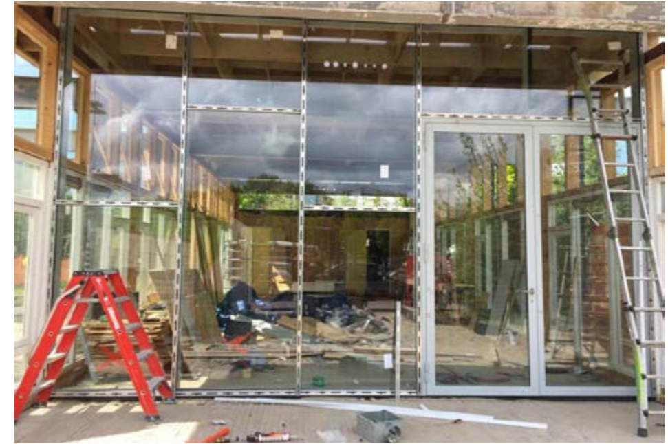
Figure 121 : Installation de la structure porteuse, deuxième phase. (Source : Blonkstaal)
